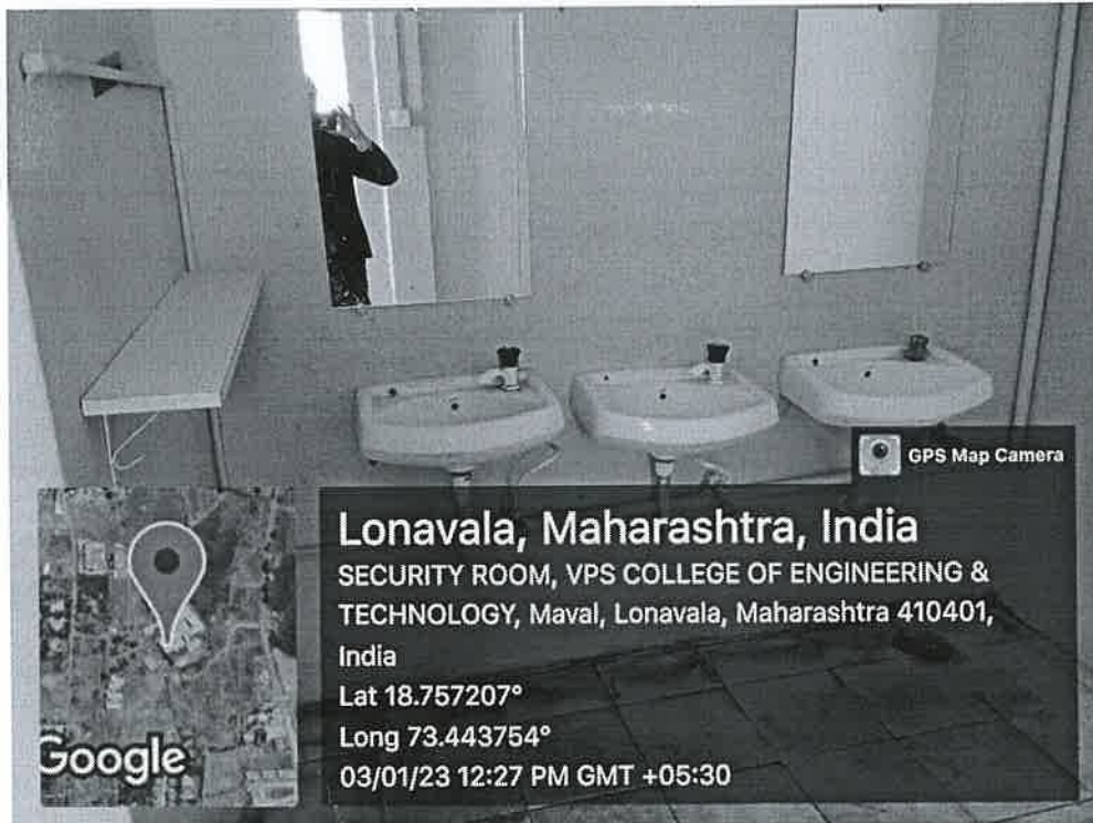
GIRLS TOILET ROOM
